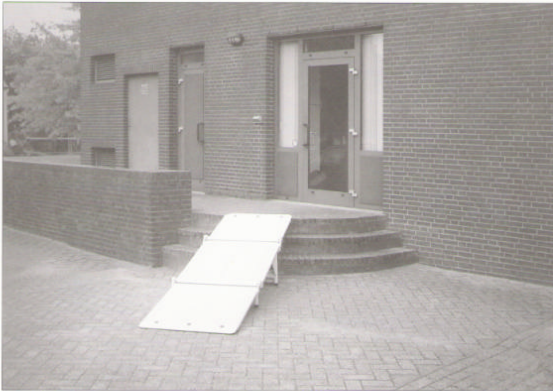
Een snelle overbrugging van meerdere treden.
